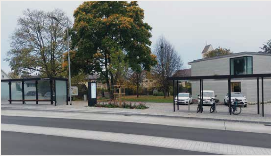
Sanierter Bereich der Kantonsstrasse mit neuem Buswartehäuschen und Velounterstand beim Gemeindehaus (Foto: Daniel Frei)
