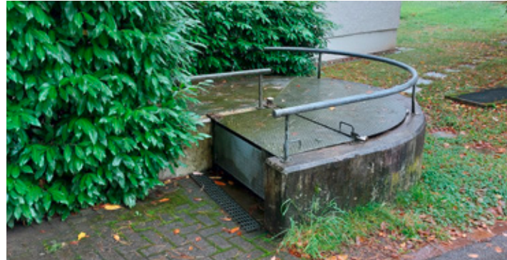
Der Eingang zum unterirdischen Regenbecken (Foto: Thomas Bussslinger)
