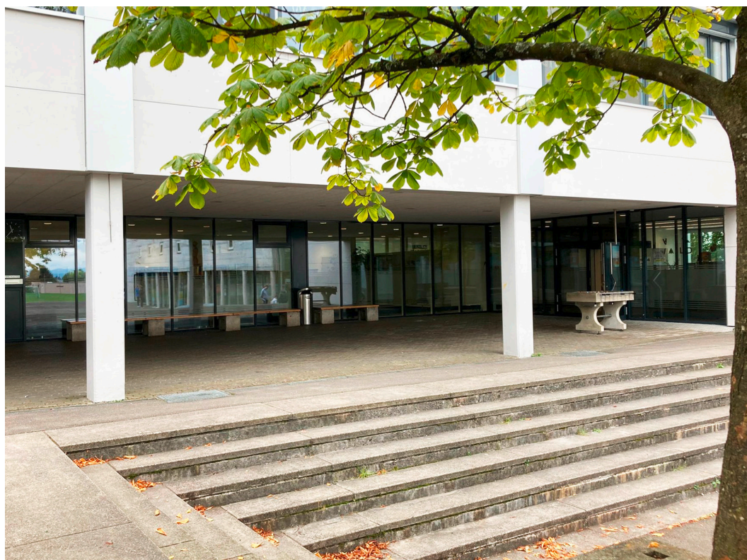
Foto des Eingangsbereichs mit sanierter Fassade (Foto: Janine Busslinger)
