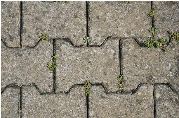
Pflasterung mit Betonsteinen (enge Fugen)
