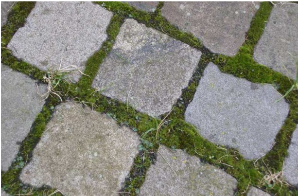
Pflasterung mit Natursteinen
