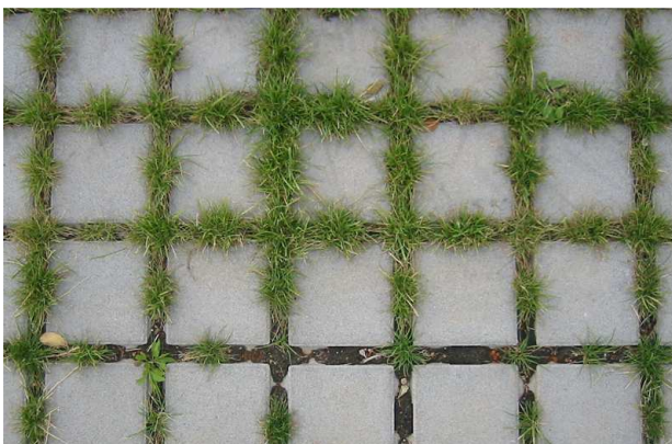
Pflasterung mit Betonsteinen (breite Fugen)
