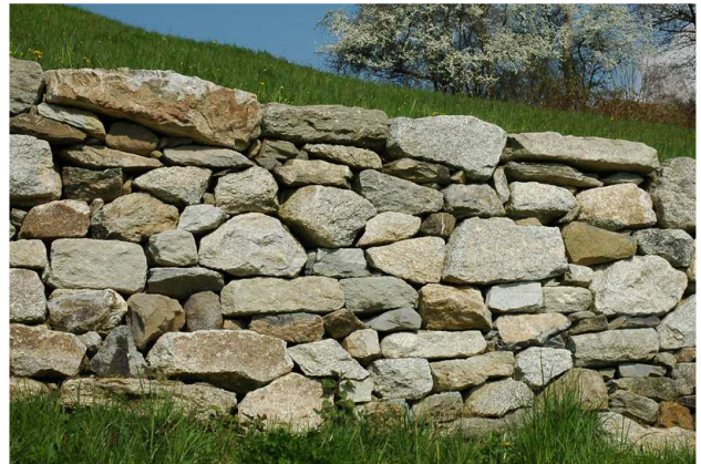
Neu aufgebaute Trockenmauer
