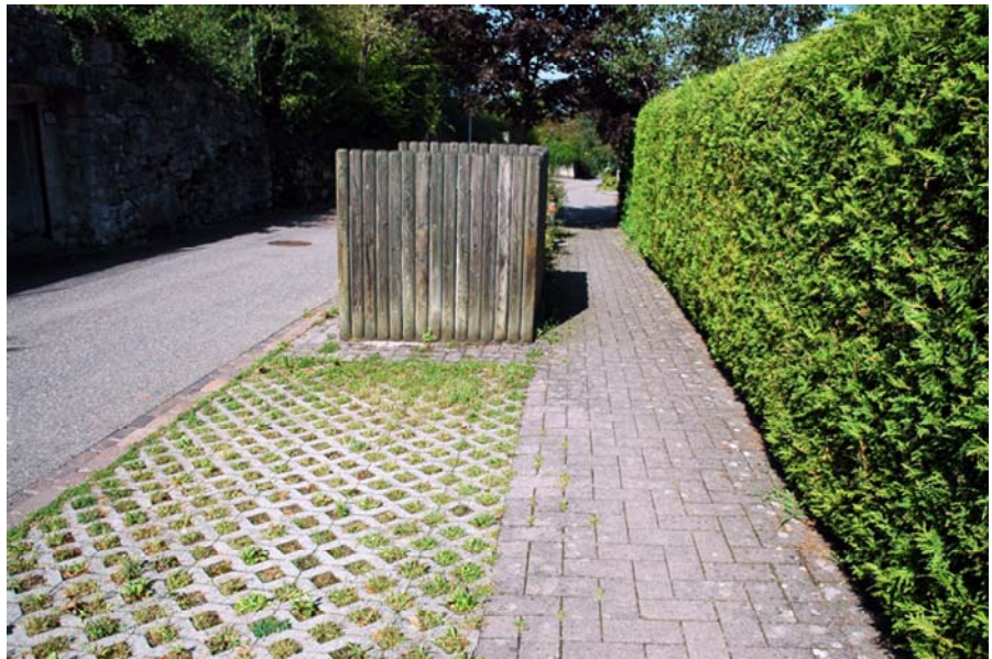
Steinpflaster-Trittflur mit Verbund- und Gittersteinen an der Buoaacherstrasse.
